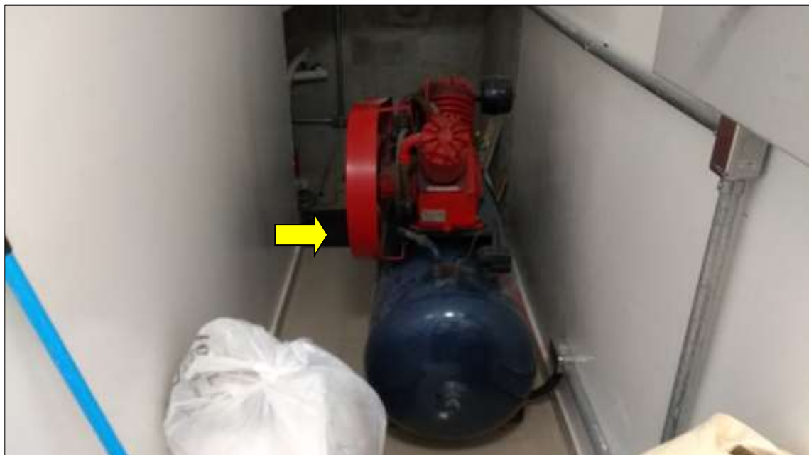
Foto 02: Detalhe do compressor de ar instalado próximo a recepção sem o necessário isolamento acústico.
